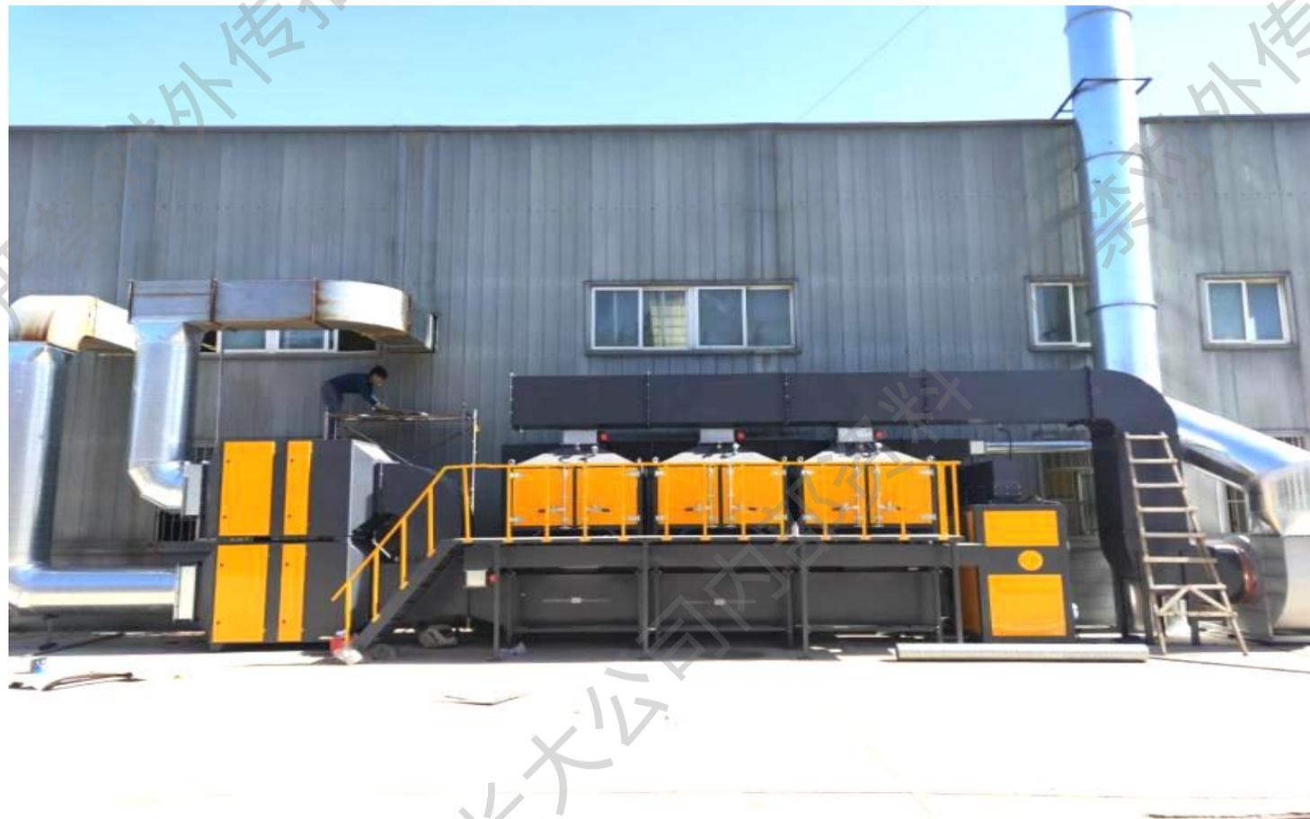
公司施工现场的沥青烟气处理装置
